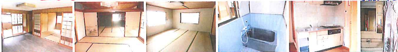
2F洋室より和室へ 1F縁側付続き間
